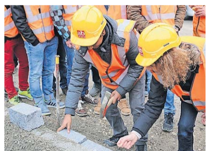
Bei Albin Borer: Randsteine setzen.
